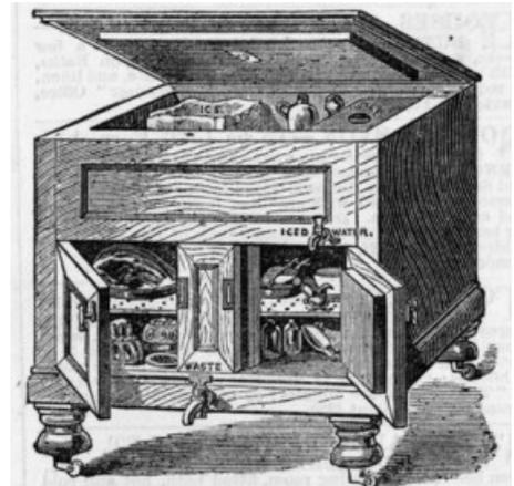
armario en cuyo interior se introducía grandes bloques de hielo. Esas cámaras se aislaban con forro de pizarra, y los alimentos se depositaban en compartimentos pequeños, ya que el hielo, junto con el material aislante, ocupaba casi todo el espacio útil. Más que frigoríficos o refrigeradores eran simples neveras que no diferían en mucho de los "armarios de nieve" del siglo XVI.
