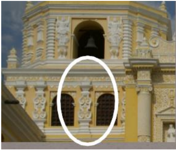
TORRE DEL CAMPANARIO DE LA IGLESIA DE LA MERCED EN ANTIGUA GUATEMALA Con una variante de la pilastra serliana
